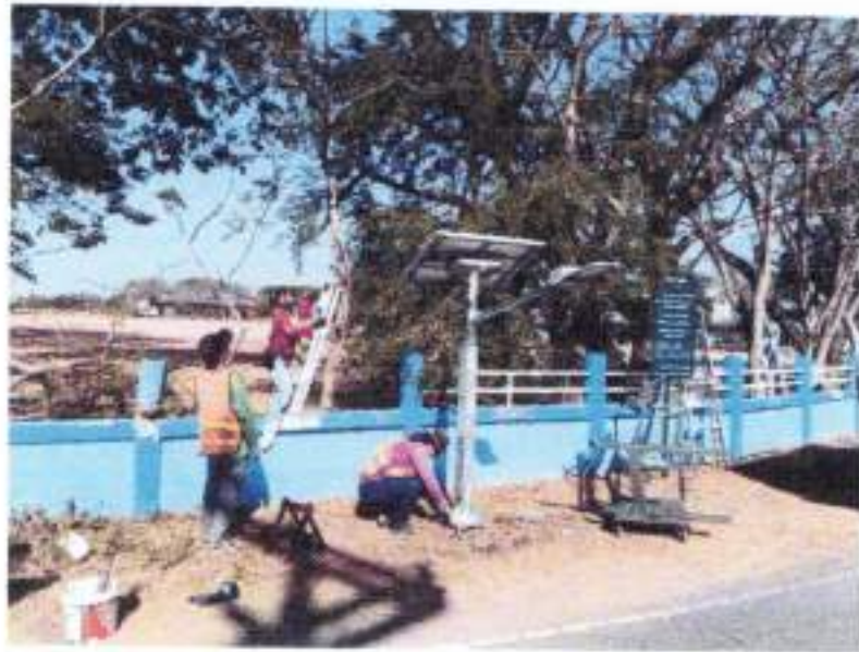
งานติดตั้งชุดโคมไฟ
